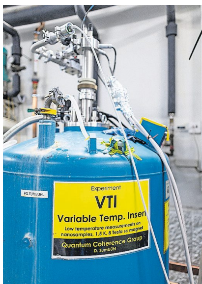
Für den Betrieb ist Kälte entscheidend.
